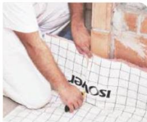
2. Fazer os cortes necessários para a correta cobertura da área a ser isolada.
