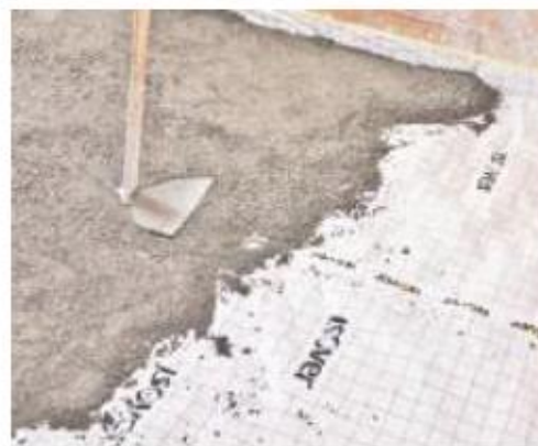
4. Despejar a primeira camada de massa com aprox. 2 cm (traço 1:2:3).
