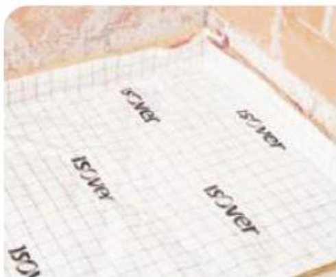
1. Estender o Optima Felt sobre a laje.
