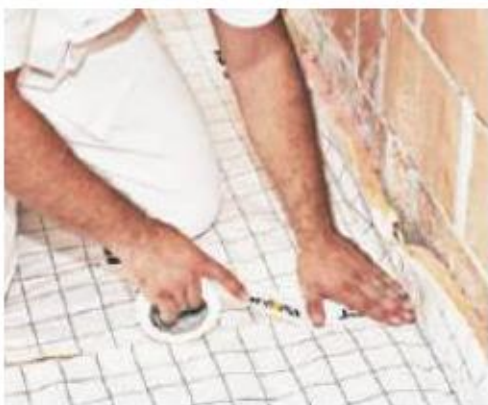
3. Unir as bordas da manta com fita adesiva de polipropileno.
