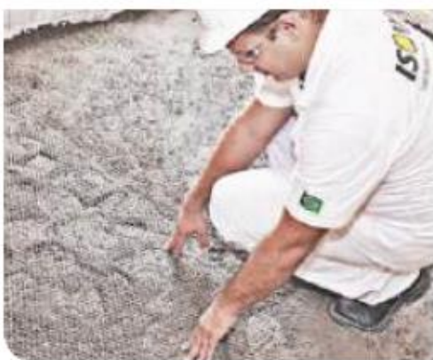
5. Colocar a tela metálica galvanizada com malha hexagonal (tipo pinteiro) sobre a camada de massa.
